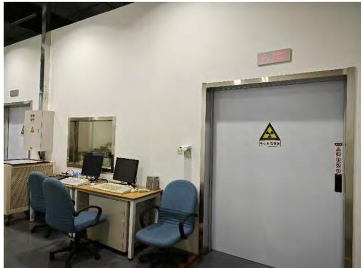
出入口设置的放射性标志、中文警示说明和“射线有害灯亮勿入”工作状态灯
